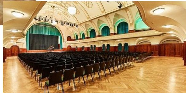
Neue Bühne (vordere Reihen/Segmente sind einzeln ausfahrbar – zuvor mussten diese per Hand in Saal geschoben werden); neues Parkett (altes nicht bauzeitlich), neue Licht- und Bühnentechnik; Restaurierung Oberflächen (u.a. Holz-sichtigkeit Türen, Wandvertäflung)
